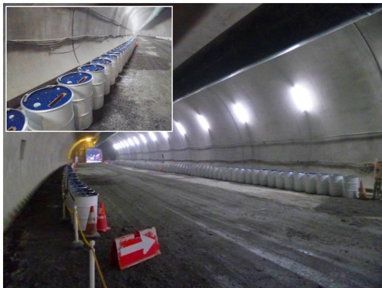
図1 円淵トンネルに設置した「ドラムサイレンサー」
