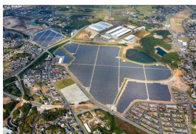
【太陽光発電所】
