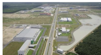
ベトナム・ロンドウック工業団地
