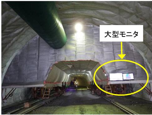
写真1 トンネル内の大型モニタ設置状況
