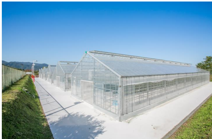
いちごハウス外観
