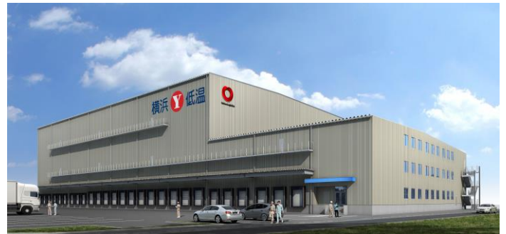
《B棟》冷凍・冷蔵倉庫
