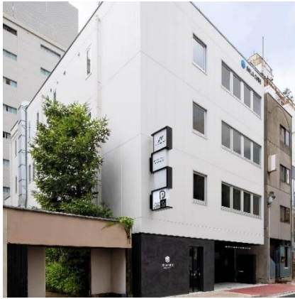
「SOLA CUBE 横濱関内」外観
