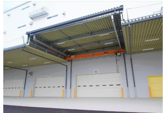
【天井クレーン】
