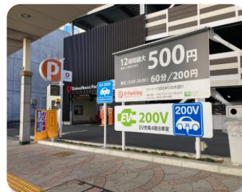
Dパーキング（EV充電サービス）
